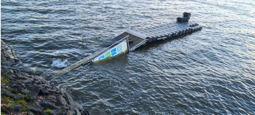
Abbildung 1: Der Steg sollte näher ans Ufer gezogen werden
